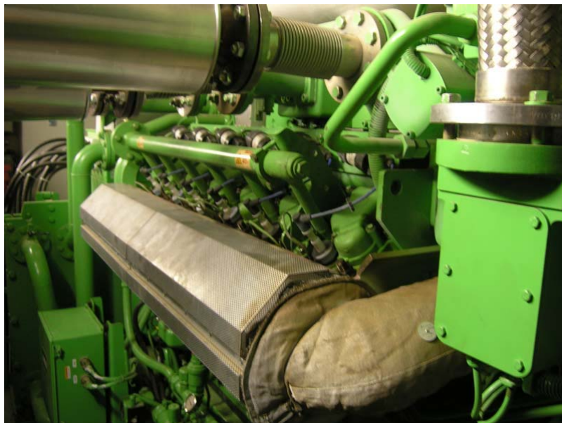
Blockheizkraftwerk
