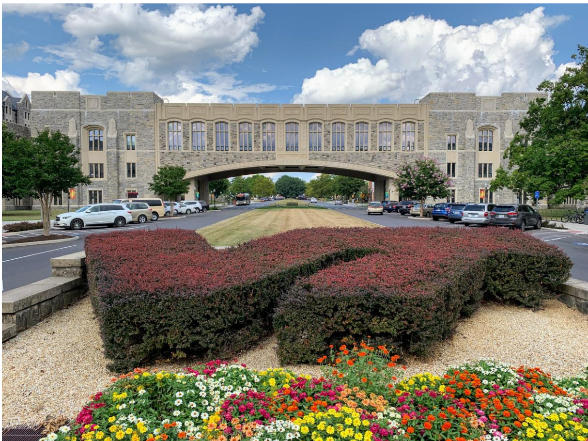
Abbildung 1.1: Torgesen-bridge im üblichen Hokie-stone Stil
