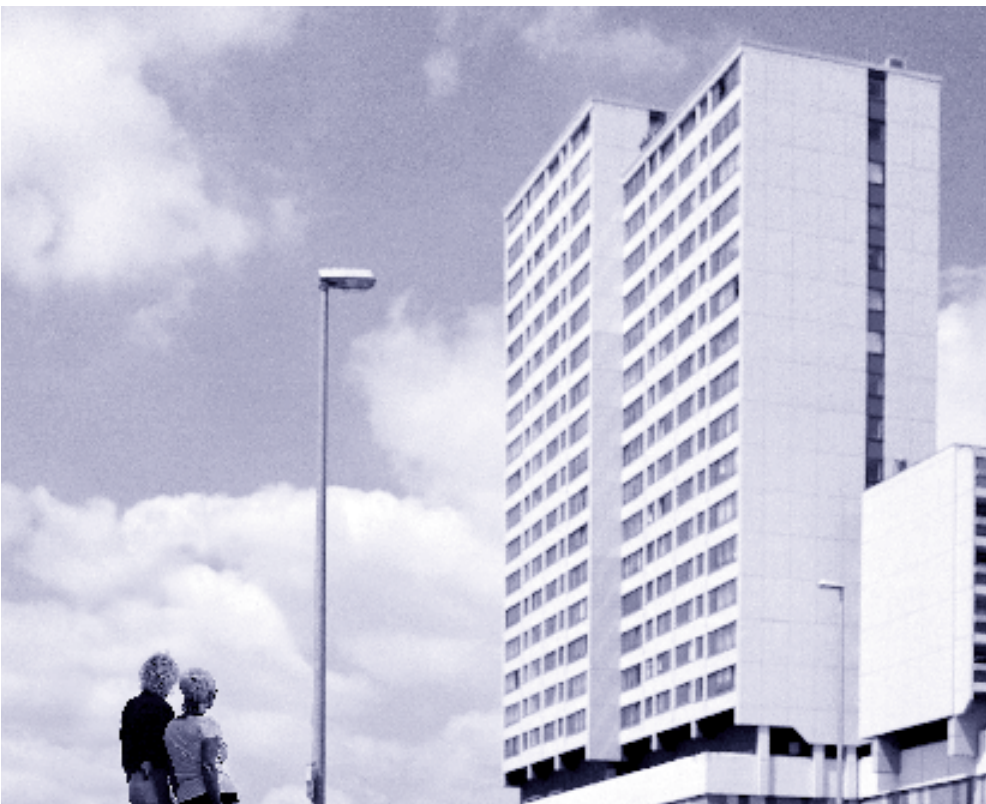
Köln-Chorweiler: Aus der neuen Stadt der 70er ist heute ein sozialer Brennpunkt geworden
