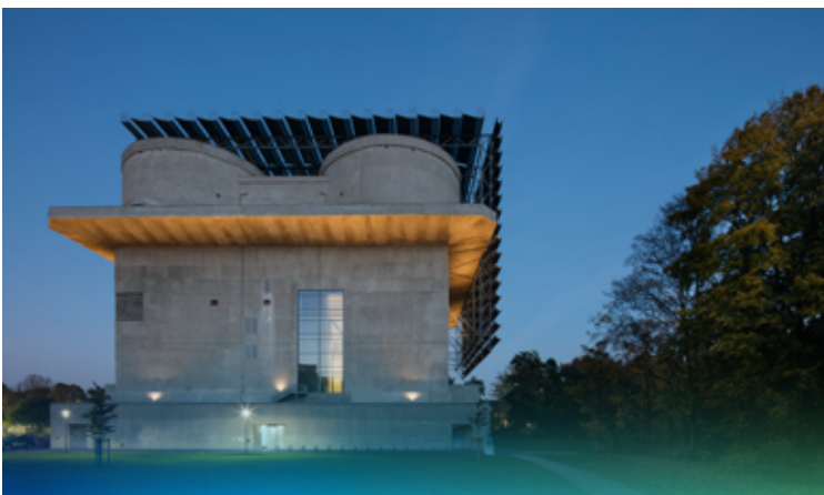
Bild: © HAMBURG ENERGIE
