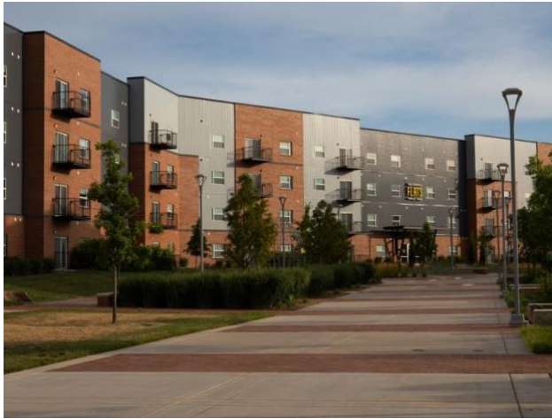
Abbildung 2: Studentenwohnheim „The Flats“
