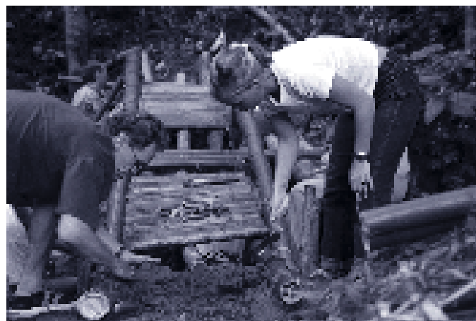
Bau einer Bambusbrücke
