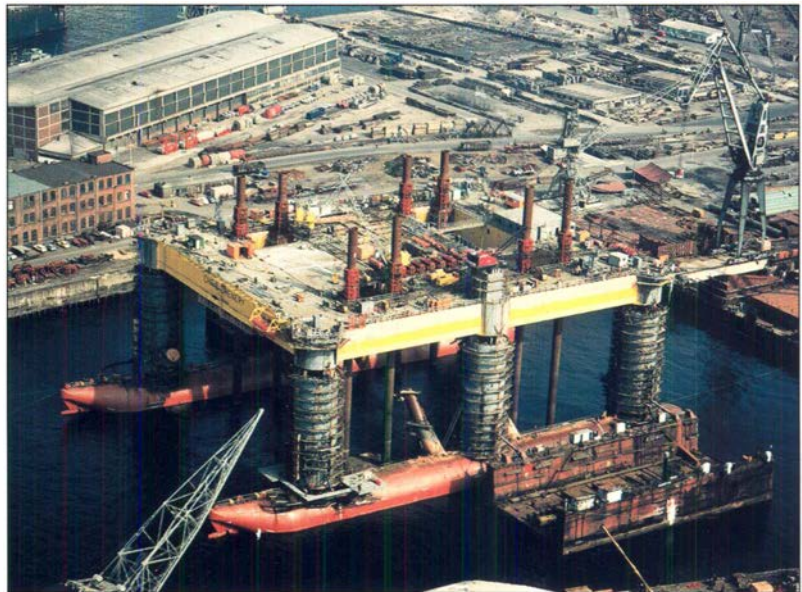
Bild 6: Montage der „Chris Chenery“
