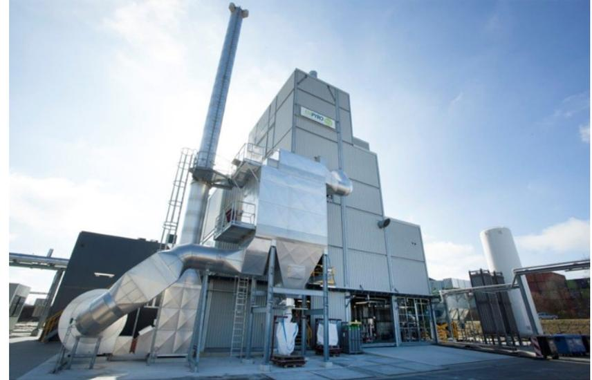
**Empyro-BTG**-Produktionsanlage in Hengelo/NL: 5 t/h Holz, 20 MW<sub>th</sub> 22
