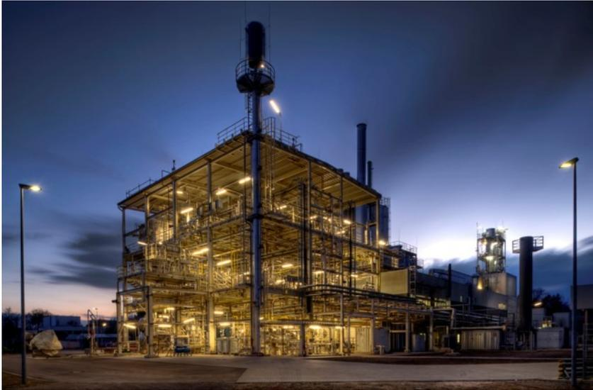
**Bioliq<sup>R</sup>**-Pilotanlage am KIT in Karlsruhe: 0,5 t/h Stroh, 2 MW<sub>th</sub>
