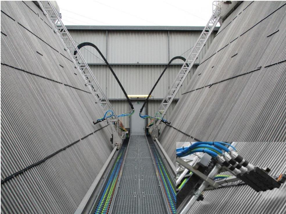
Abbildung 2: Beispiel für eine automatisierte Reinigungsanlage JetMasterAS der Firma mycon GmbH
