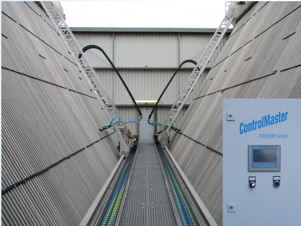
Die Düsen fahren die Oberfläche des Kondensators vollautomatisch ab
