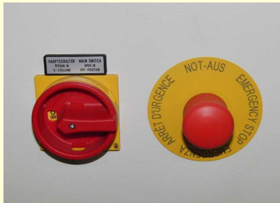
Hauptschalter und Not-Aus-Taster
