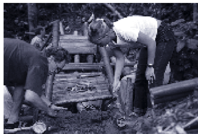
Bau einer Bambusbrücke
